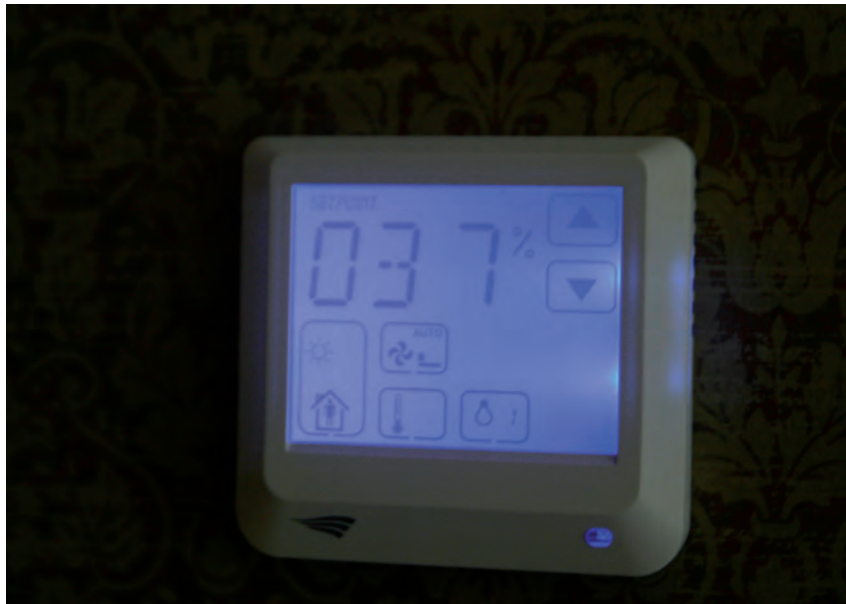
△ De thermostaat in de woonkamer geeft de vulstatus van de buffer aan, nu 37%.
